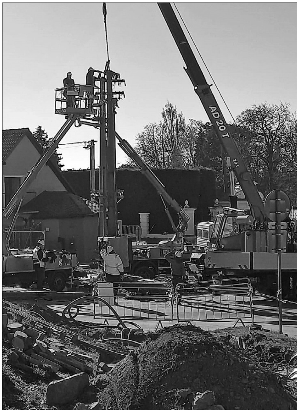
Odstranění trafostanice
