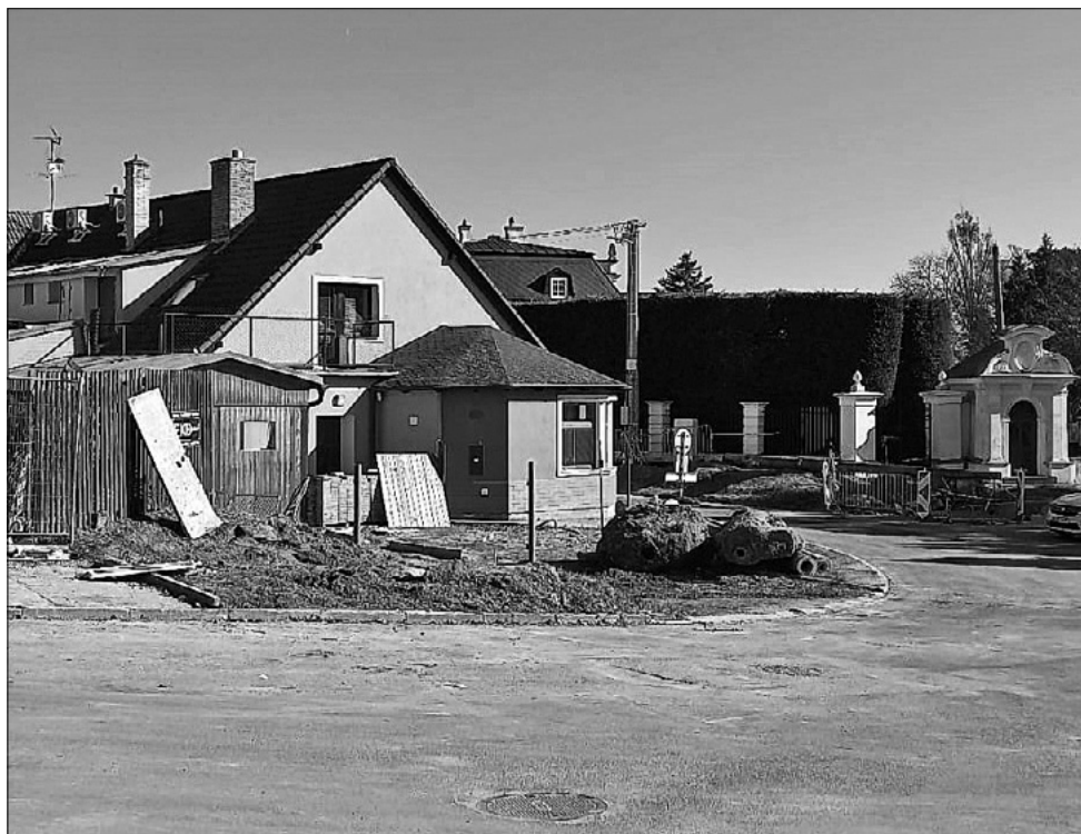
Křižovatka po odstranění trafostanice.
