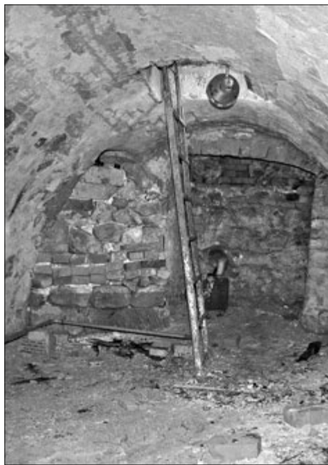
Interiér sklepa pod domem čp. 14 se zazděným schodištěm
