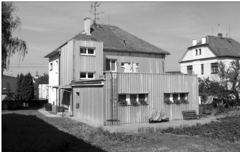
Bytový dům vedle základní školy, patřící městyši Buchlovice, prošel v nedávné době malou proměnou. Proběhla druhá etapa (první se uskutečnila v létě loňského roku) výměny původně dřevěných, dosluhujících oken a dveří, za nové. (foto -bž-)
