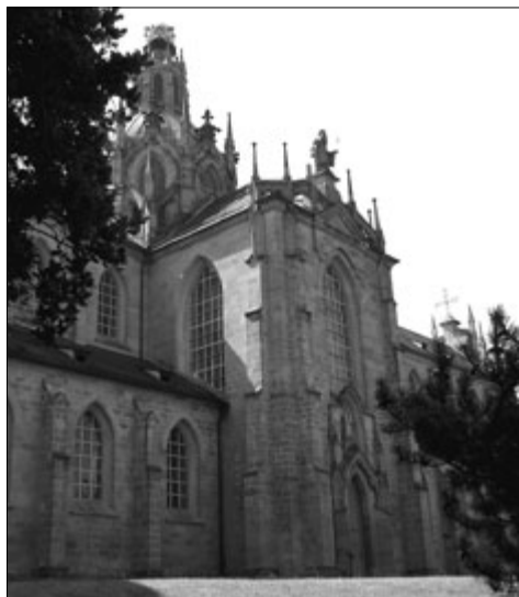
Průčelí kladrubského chrámu
