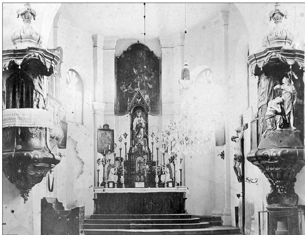
Interiér presbyteria buchlovického kostela se snesenou klenbou (foto po roce 1900)
