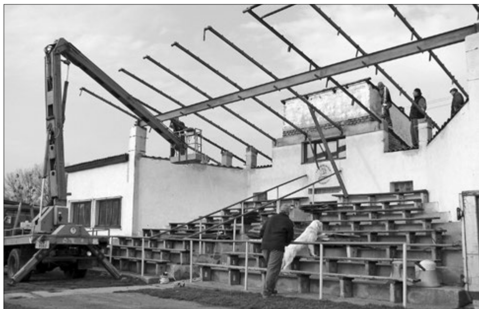
Kompletní výměna střechy tribuny
