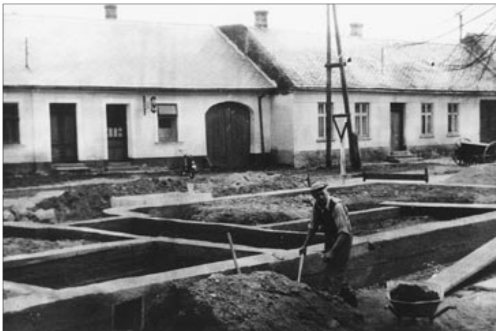
Stavba budovy holičství na náměstí (šedesátá léta)
