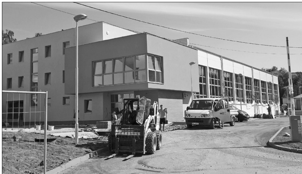
Stavba víceúčelové sportovní haly
